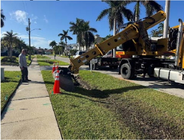
Swale grading at N. Bahama
